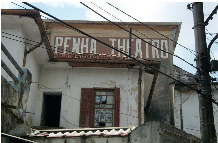
Fachada com as inscrições “Penha Teatro”, vistas da rua Capitão Avelino Carneiro, na Penha (Crédito: Caroline Aragaki)
